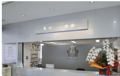
会計窓口の照明 天井にE-CORE60、文字裏にはLEDライン器具で照明
