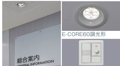
案内板にはLEDユニバーサルダウンライトで照明
