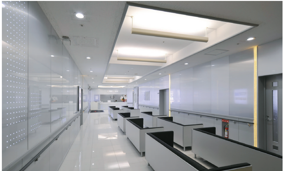
総合待合室の照明 下り天井の両側にE-CORE60を、診察室のドアわきにはLEDライン器具を、壁には透過壁材内部にLEDライン器具を設置
