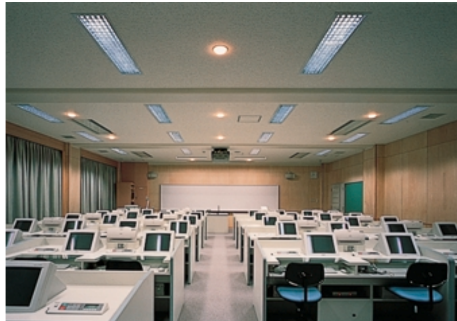
視聴覚室 40W蛍光灯2灯用埋込OALルーバー付器具を使用し、機器画面の映り込みを防止している。 Audio-visual room
