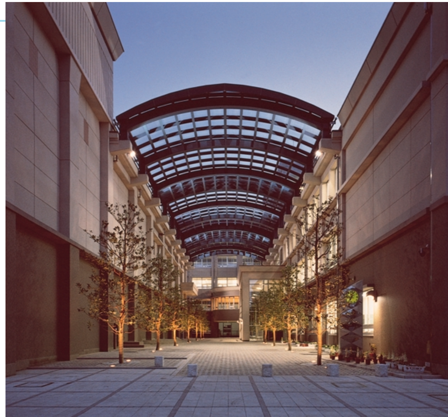
アトリウム HQI小形投光器を上部に設置し、空間照明を演出。下部にはブラケットを配置し、足元を照明。 Atrium
