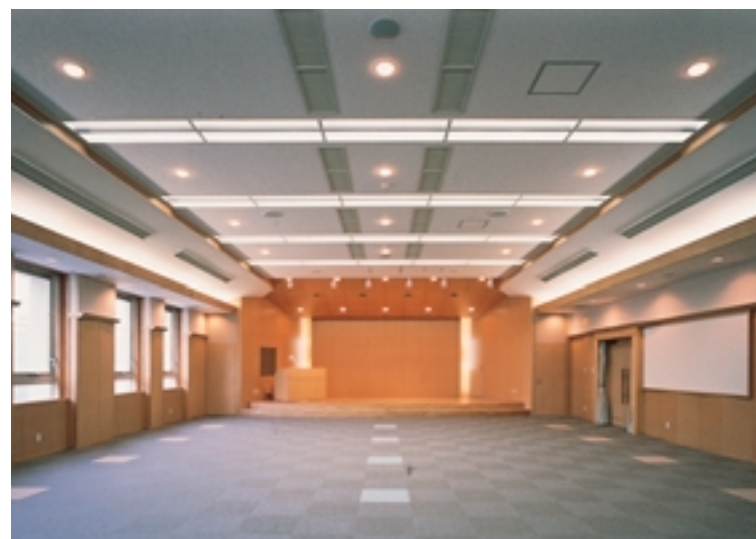
国際コミュニケーションホール International Communication Hall 40W蛍光灯3灯用間接照明器具を採用。柔らかな光空間を創出している。
