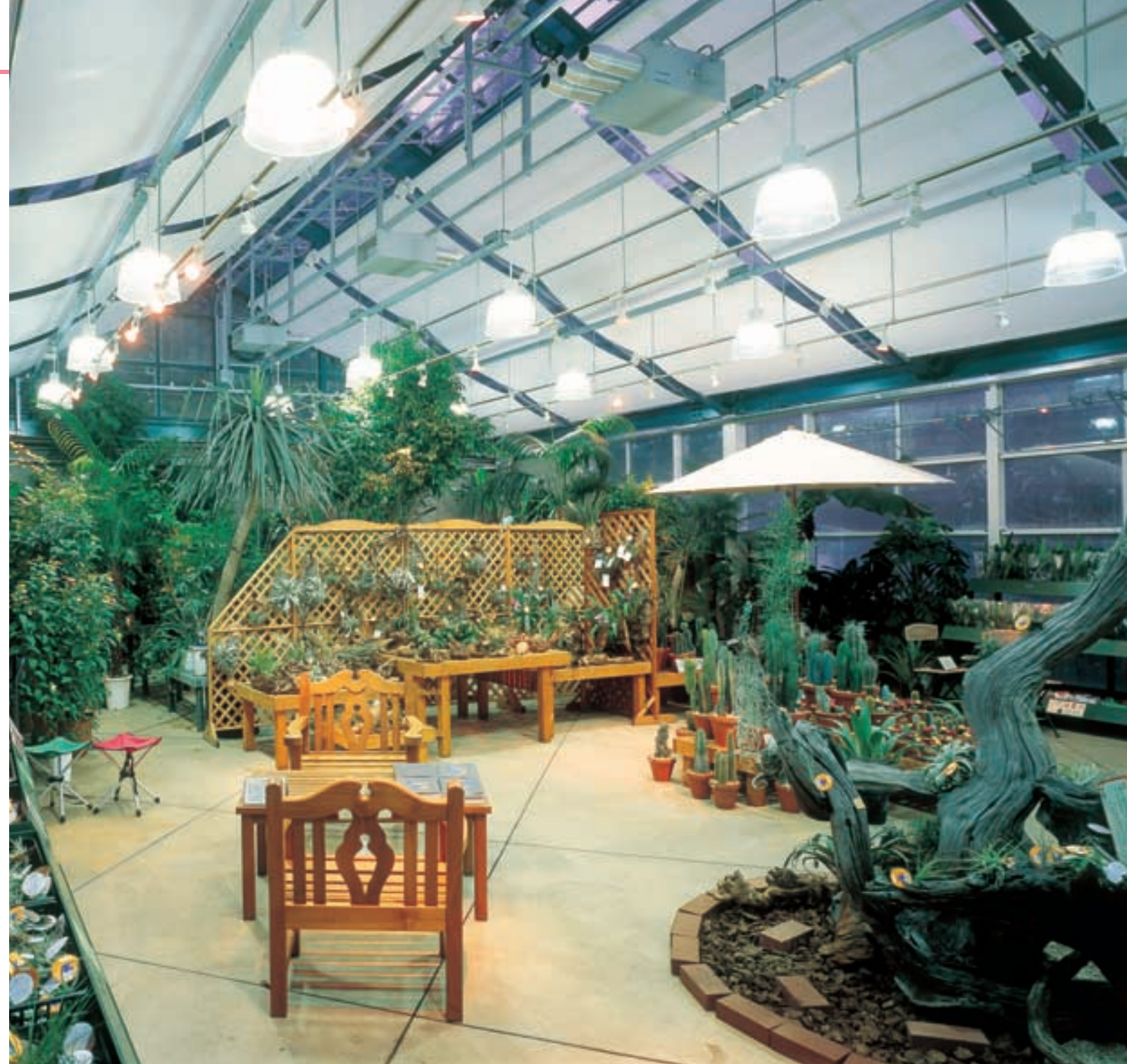
地下2階温室 ロフトペンダント器具を亚克力セード仕様とすることで、器具下だけでなく、空間照度も効率良く確保している A greenhouse, 2nd basement
