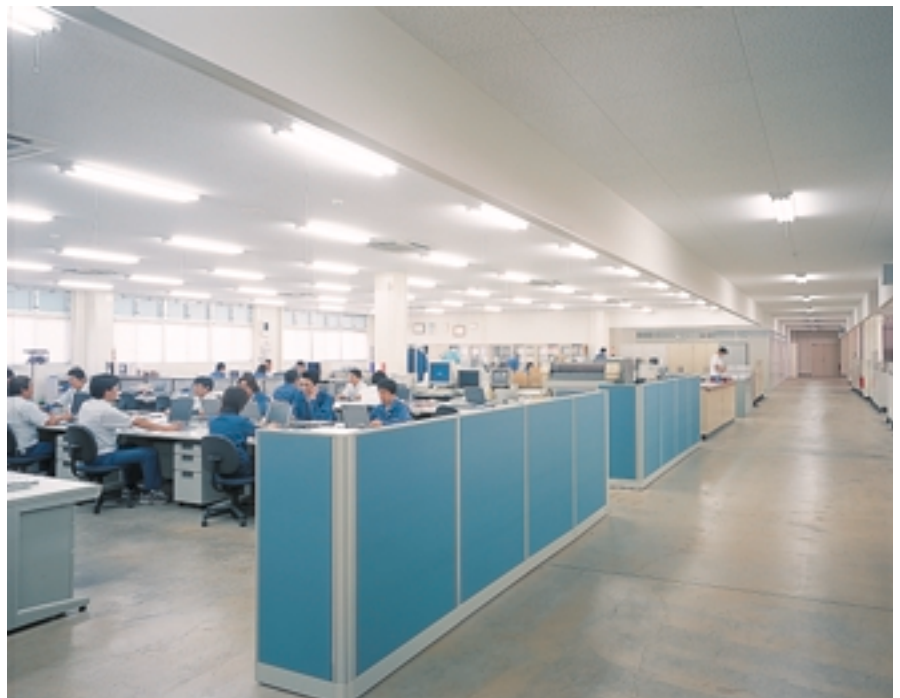
2階事務所。32WHf蛍光ランプ2灯用逆富士形器具を整列配置し、プルスイッチでの点滅を可能にして、高照度化と省エネに配慮している
