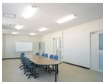
会議室。32WHf蛍光ランプ2灯用逆富士形器具に別置形の人感センサを組合わせ、消し忘れなどを防止している
