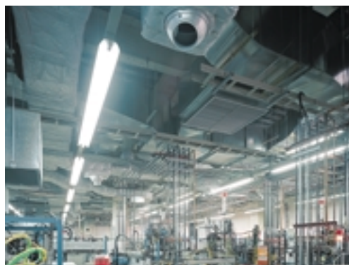
2階事務所。32WHf蛍光ランプ2灯用逆富士形器具を整列配置し、プルスイッチでの点滅を可能にして、高照度化と省エネに配慮している
