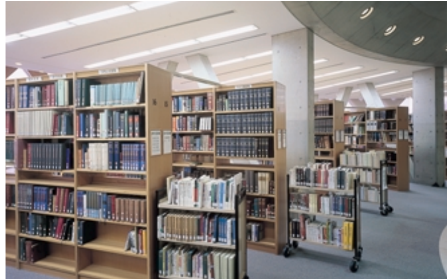
書架スペース 書架と書架の間をライン配置されたHf蛍光灯ランプが均等に照射している。 Space for book shelves
