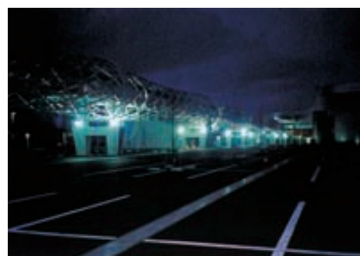
ペDESTリアンデッキ-1(ライトアップ) Pedestrian deck (lighted up) アップライトにより、幻想的に浮び上がる
