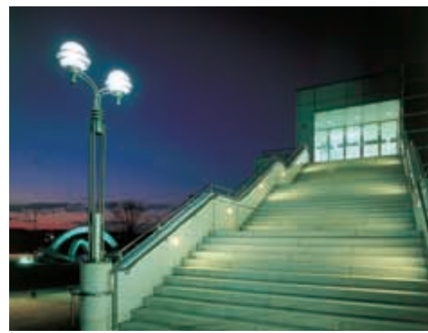
外階段 Outside stairway
