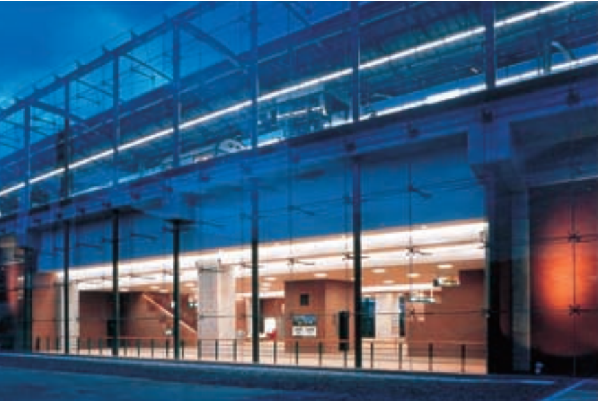
外から見るコンコース部
