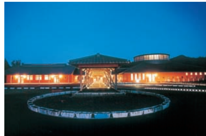
外観(薄暮時) もれ光により美しい外観 Outside view (before dark)
