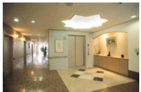
エレベーターホールは蛍光灯の建築化照明をベースに、27Wユークライン蛍光灯ダウンライトや廊下には白熱灯、ブラケット、足元灯を使用し、高齢者にやさしい照明演出となっている
