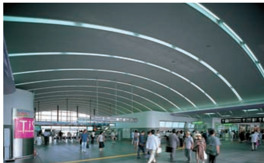
橋上駅自由通路 天井のなだらかなアームに則した照明配置で、ゼブラ模様の光のパターンをつくり出している。 Free bridge passage of the station
