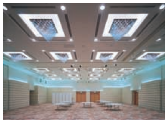
「ホテルグランヴィア京都」の中宴会場「古今の間」 A medium-sized banquet hall "Kokon no Ma" in the Hotel Granvia Kyoto 12V20Wハロゲンランプ28灯のシャンデリア。RGB調光照明により様々な演出が可能。
