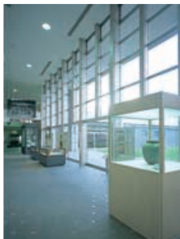
エントランスホールの照明 Lighting in the Entrance Hall HID埋込ダウンライトにより、外光との違和感のない光色で、明るく開放的な照明空間が得られている
