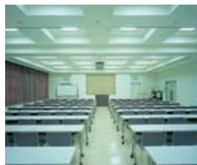
研修室の照明 Lighting in the Seminar Room 建築による折上天井内に方向性のない乳白カバー付器具を採用し、個々の折上天井を光天井にイメージしている
