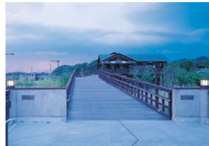
ゲート付近景観 View near the gate 旧野田橋の門柱灯をイメージしたデザイン器具が橋上へと導く
