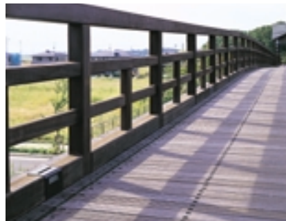
フットライト Footlights 高欄下段内に器具を埋め込む
