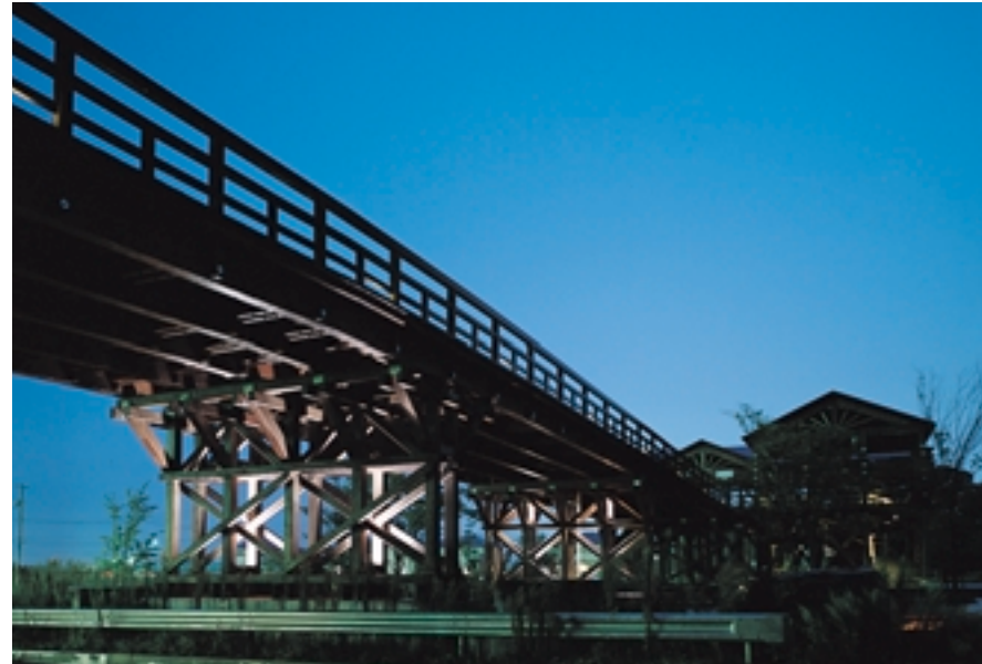
橋脚ライトアップ ライトアップ(手前)とライトダウン(奥)、異なる照明手法を用いてライトアップを行う Light-up of bridge pier
