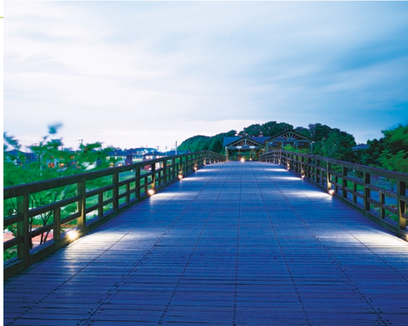
橋上の照明環境 フットライト(電球色)による光の帯が橋上に連なり、温かみのある照明環境を創造する Illumination effect on the bridge
