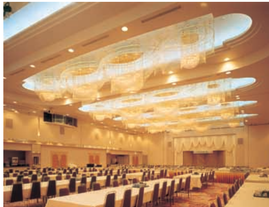
5階 多目的ホール“クイーンエアリザベス” Multi-purpose hall on 5th floor 7500W×1350の大型シャンデリアを3台設置。光源はミニクリプトンランプ40W×76灯を使用。
