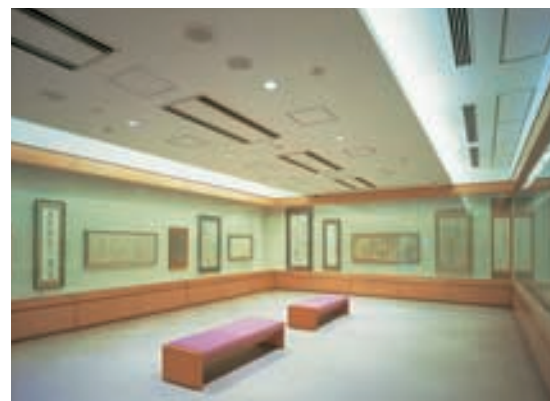
第一展示室 Exhibition Hall No.1 ベース照明にはHfシリーズによる建築化照明とメタルハライドランプダウンライトを採用
