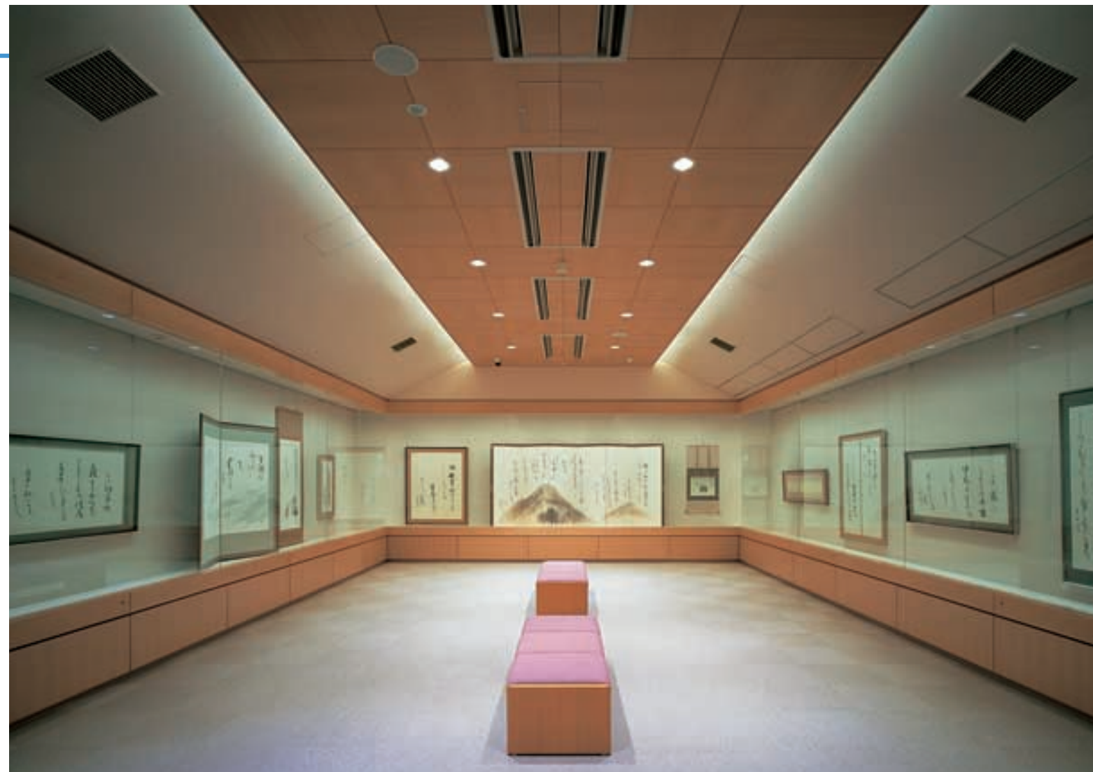
第二展示室 Exhibition Hall No.2 掘り上げ天井内にコープ照明手法を採用した建築化照明。固定ケースの前面ガラスへの映り込みが少なく、品格のある展示照明環境を演出
