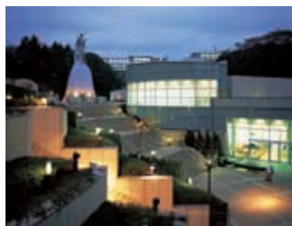
景観照明 Lighting vista 低ボール灯を採用し、周辺環境との調和と、容易なランプ交換を可能にすることを配慮
