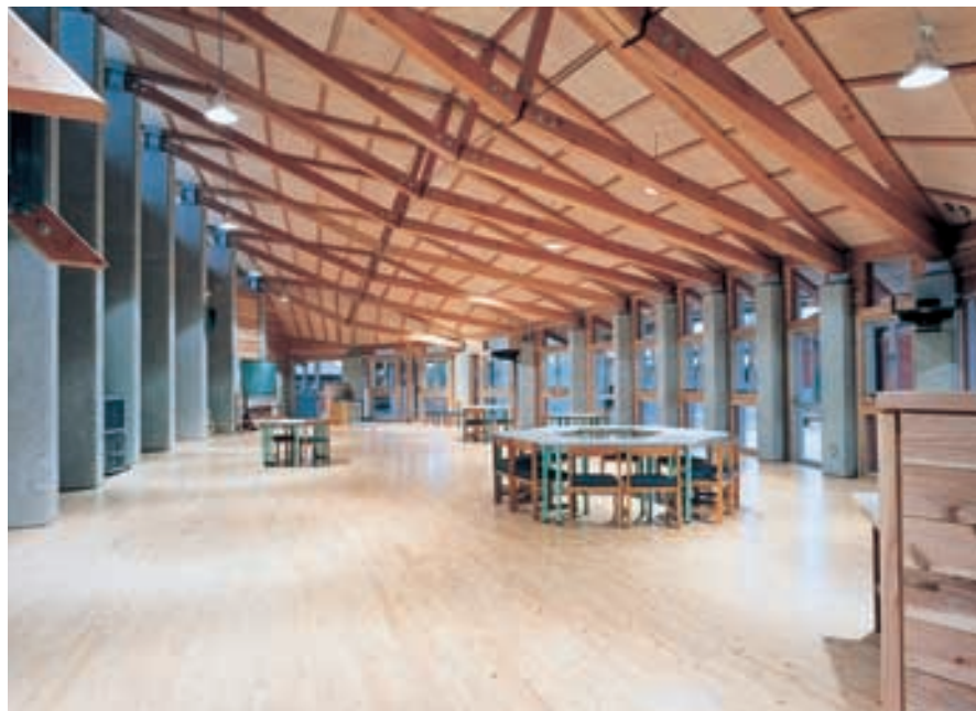
多目的ホール Multi-purpose hall 特徴的な木造屋根組の開放的な空間を爽やかな照明空間にしている。
