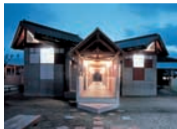
渡り廊下 Passage connecting two buildings 各教室とは異なる暖かみのある光色の60W電球ブラケットでゾーニング。
