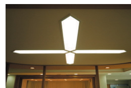
メディアステーション：円形開架コーナーの下がり天井部には、32WHiF蛍光ランプ2灯用埋込カバー付特注器具を4台組合わせて設置
