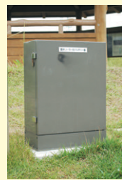
ハイブリッドソーラーライトのインバータ・バッテリー盤
