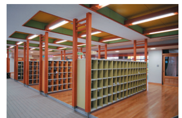
靴箱：折上げ天井内に梁状の照明ボックスを設け、その中に32WHiF蛍光ランプ1灯用直付器具を取付けている
