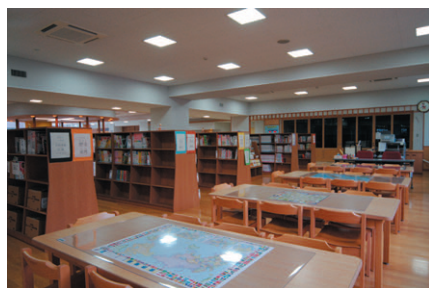
図書室：開架式の図書室では、方向性のない36Wコンパクト形蛍光ランプ3灯用カバー付スクエア器具を採用
