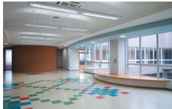
ラウンジ・ギャラリー：32WH蛍光灯2灯用の吊下げOAソフトを2連結でパイプ吊りし、天井面にも光を反射させている
