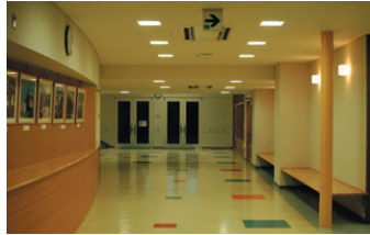
ホール：音楽室前のホールは、36Wコンパクト形蛍光灯2灯用スクエア器具と電球ブラケットで落ち着いた雰囲気
