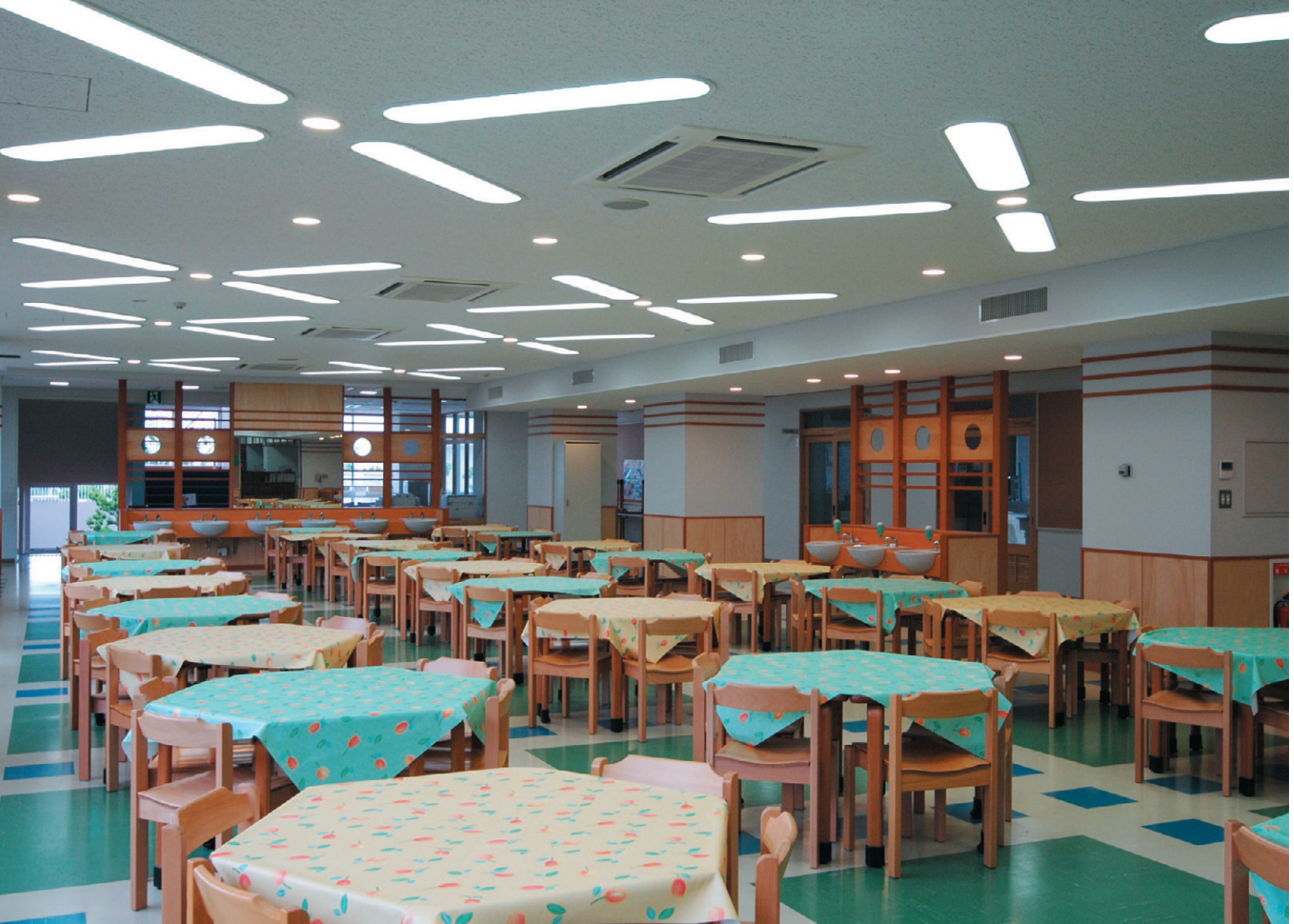
ランチルーム：子供たちが楽しく食事できるように、32WHiF蛍光ランプ2灯用長円形器具を花びらの形に組合わせた照明
