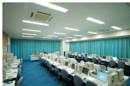
コンピュータ室：32WHiF蛍光ランプ2灯用器具を整理配置。机を直交させて配置し、画面への映り込みをなくしている
